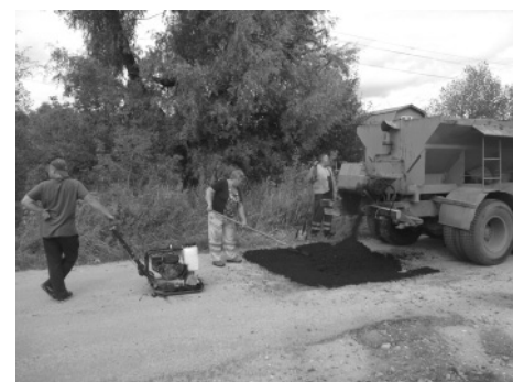
Ямочный ремонт в с. Федино
