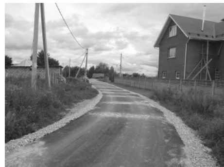
Дорога д. Аргуново после ремонта
